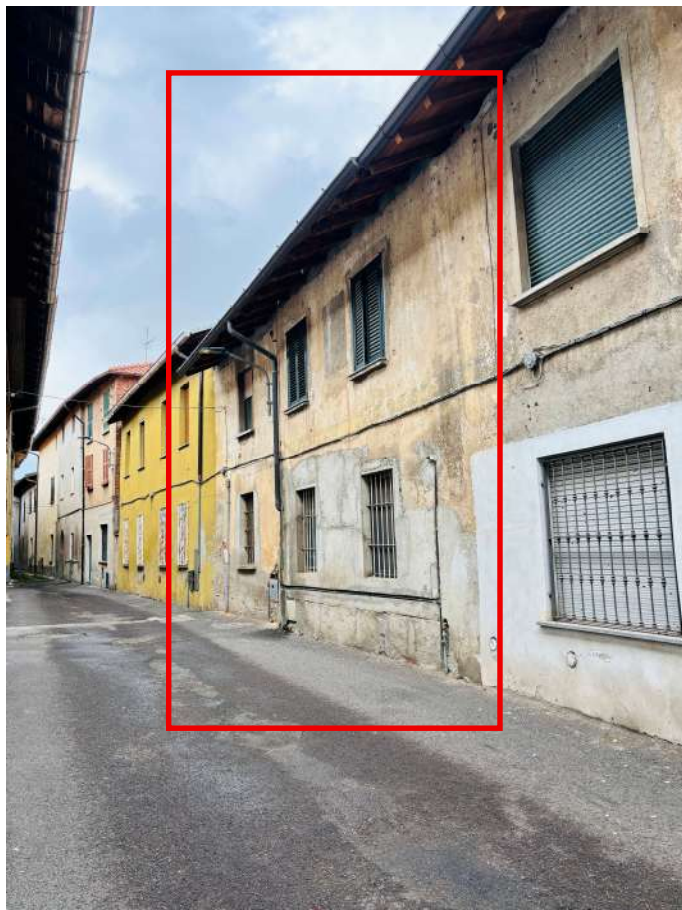
Fotografia 31. Prospetto su via G. Zaffaroni.
