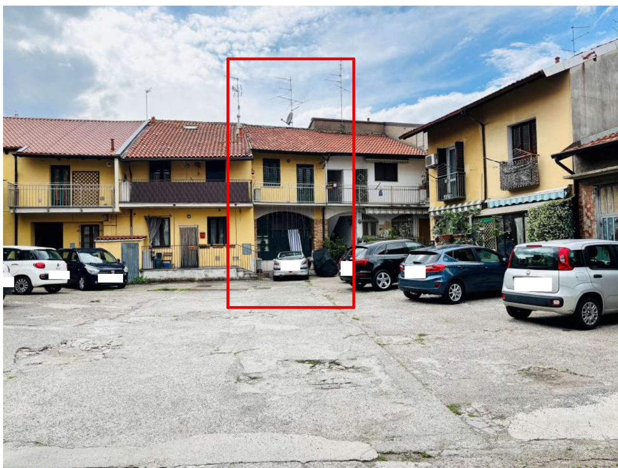
Fotografia 02. Vista da corte interna.
