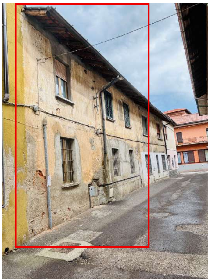
Fotografia 32. Prospetto su via G. Zaffaroni.
